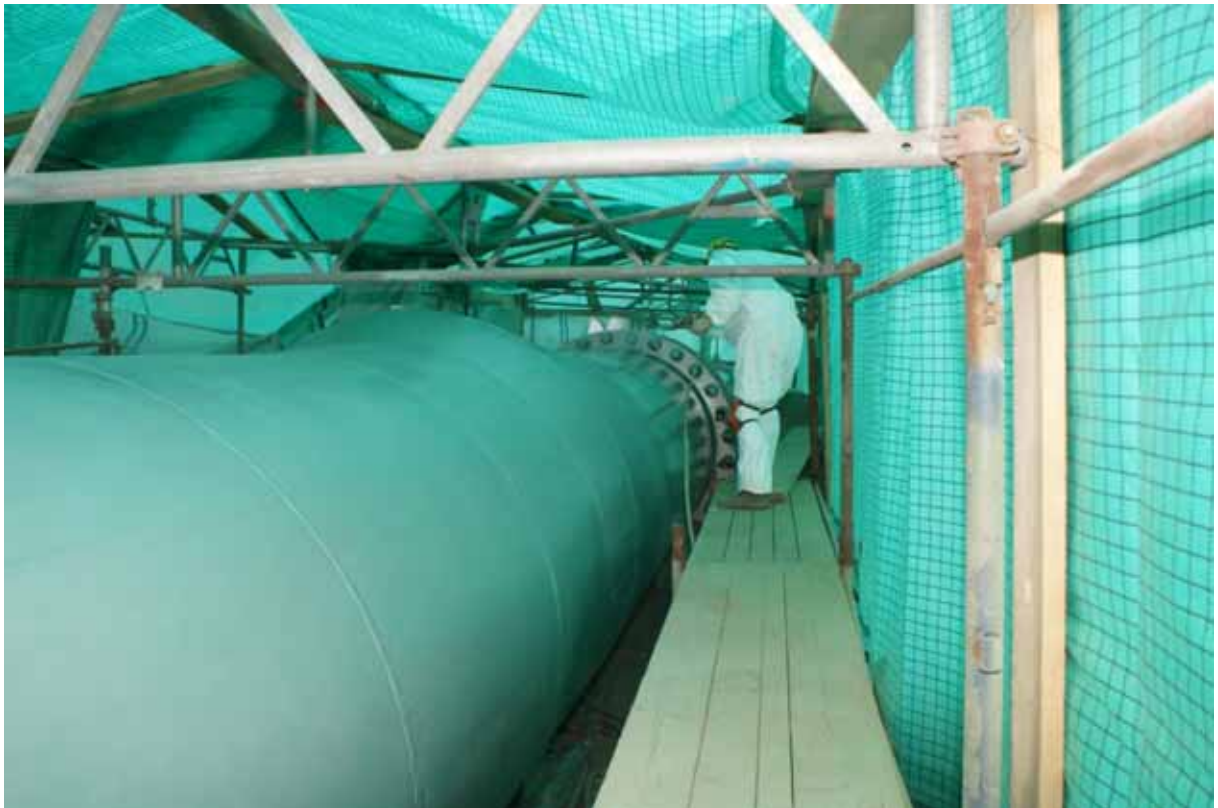
Bild: Applikation von Gens Final CR auf die Humidur-Beschichtung.
