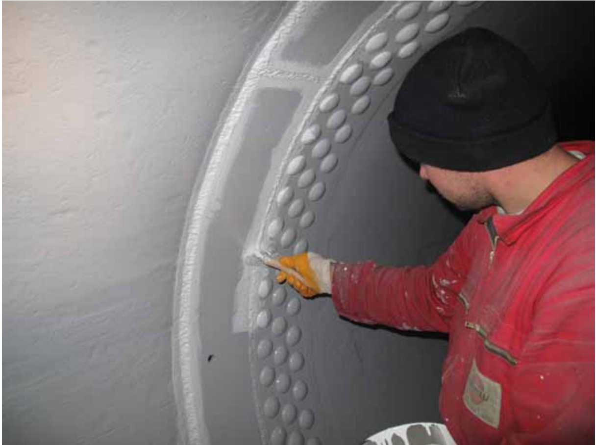
Bild: Die Schweißnahtbereiche und Nietenreihen wurden mit Humidur BAME im Farbtonwechsel vorgestrichen.
