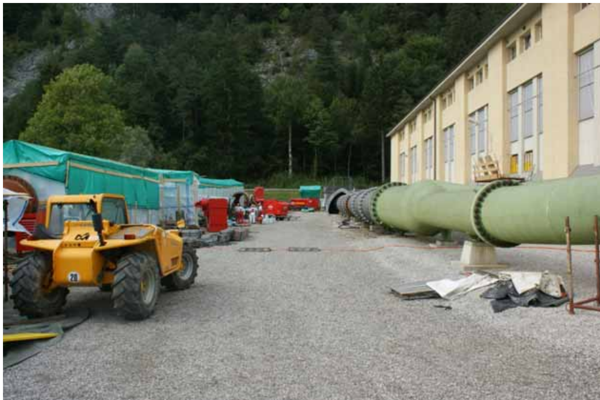
Bild: alte Verteilrohrleitung in silber und 2004 erneuerte Verteilrohrleitung in grün.
