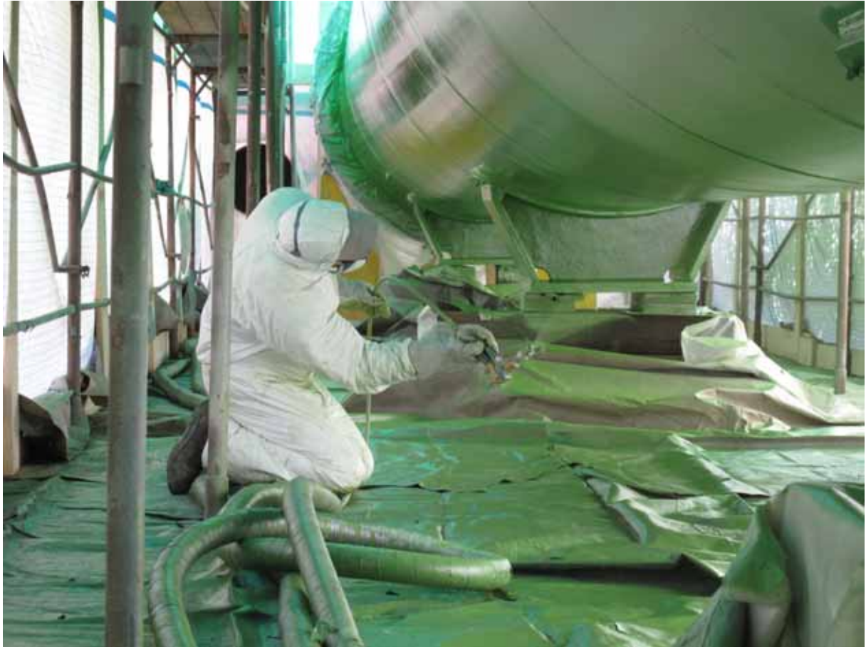
Bild: Applikation der zweiten Schicht Humidur im Farbton maigrün auf der Außenseite.
