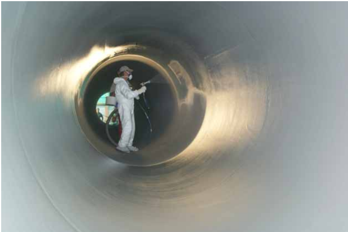
Bild: Applikation der ersten Schicht Humidur im Farbton lichtgrau
