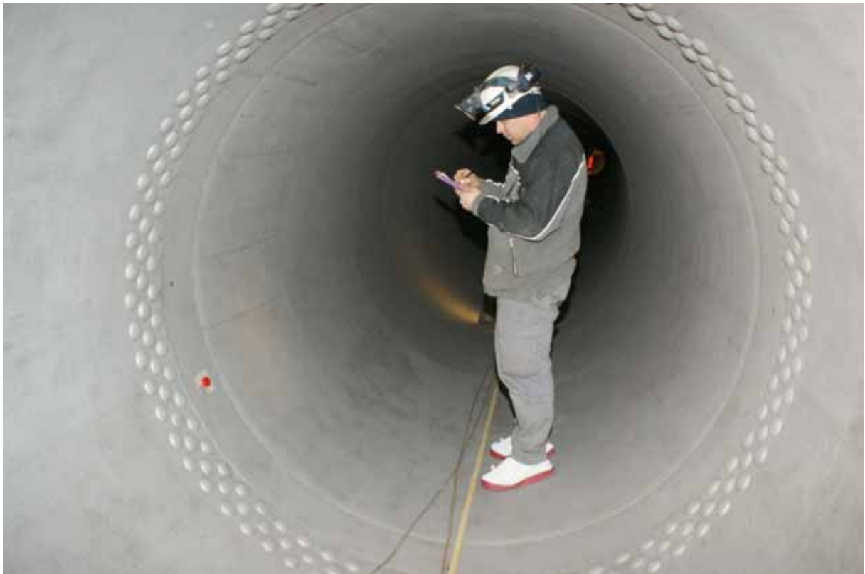
Bild: Sandstrahlabnahme im verbleibenden alten Teil der inneren Verteilrohrleitung-Flachstrecke. Die Staubfreiheit wird mittels Klebebandtests auf die Erreichung des Reinheitsgrades m^2/g^2 geprüft (DIN EN ISO 8502, Teil 3).
