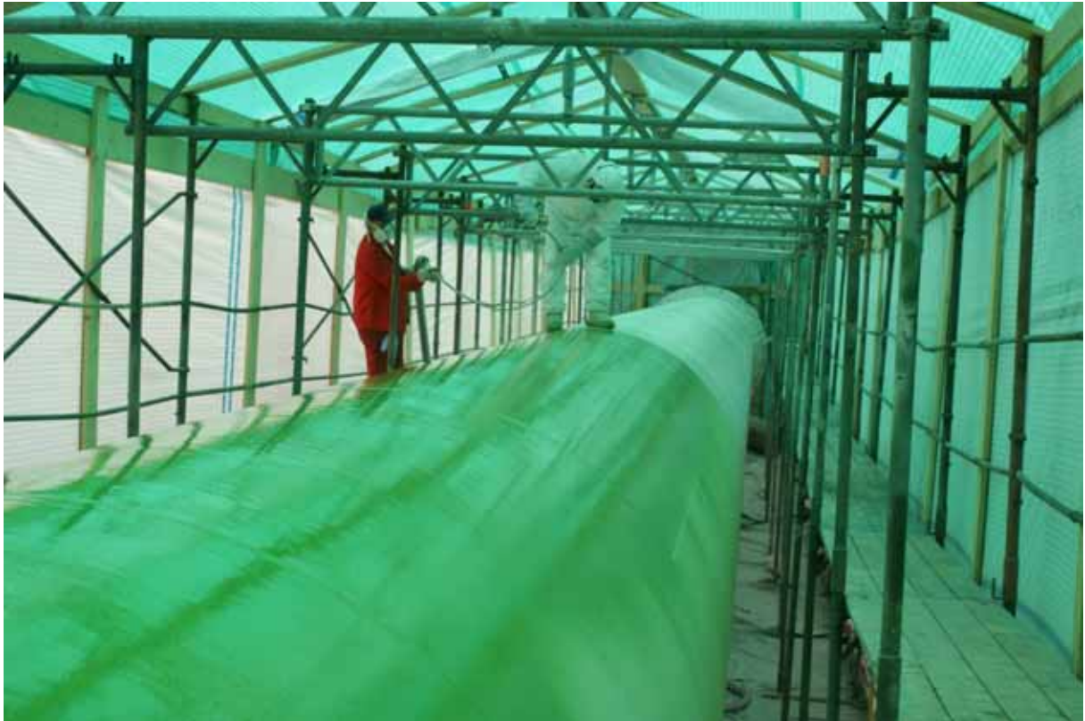
Bild: Applikation der zweiten Schicht Humidur im Farbton maigrün auf der Außenseite.
