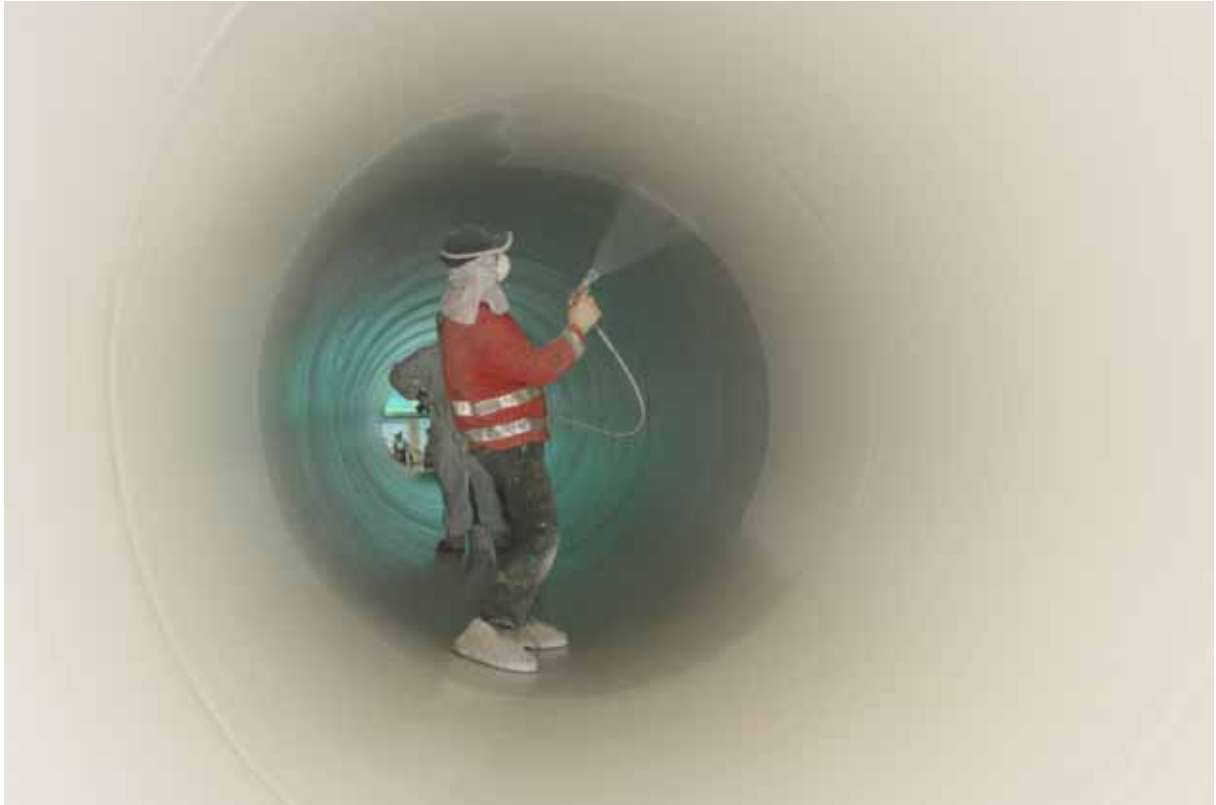
Bild: Applikation der zweiten Schicht Humidur im Farbton weiß
