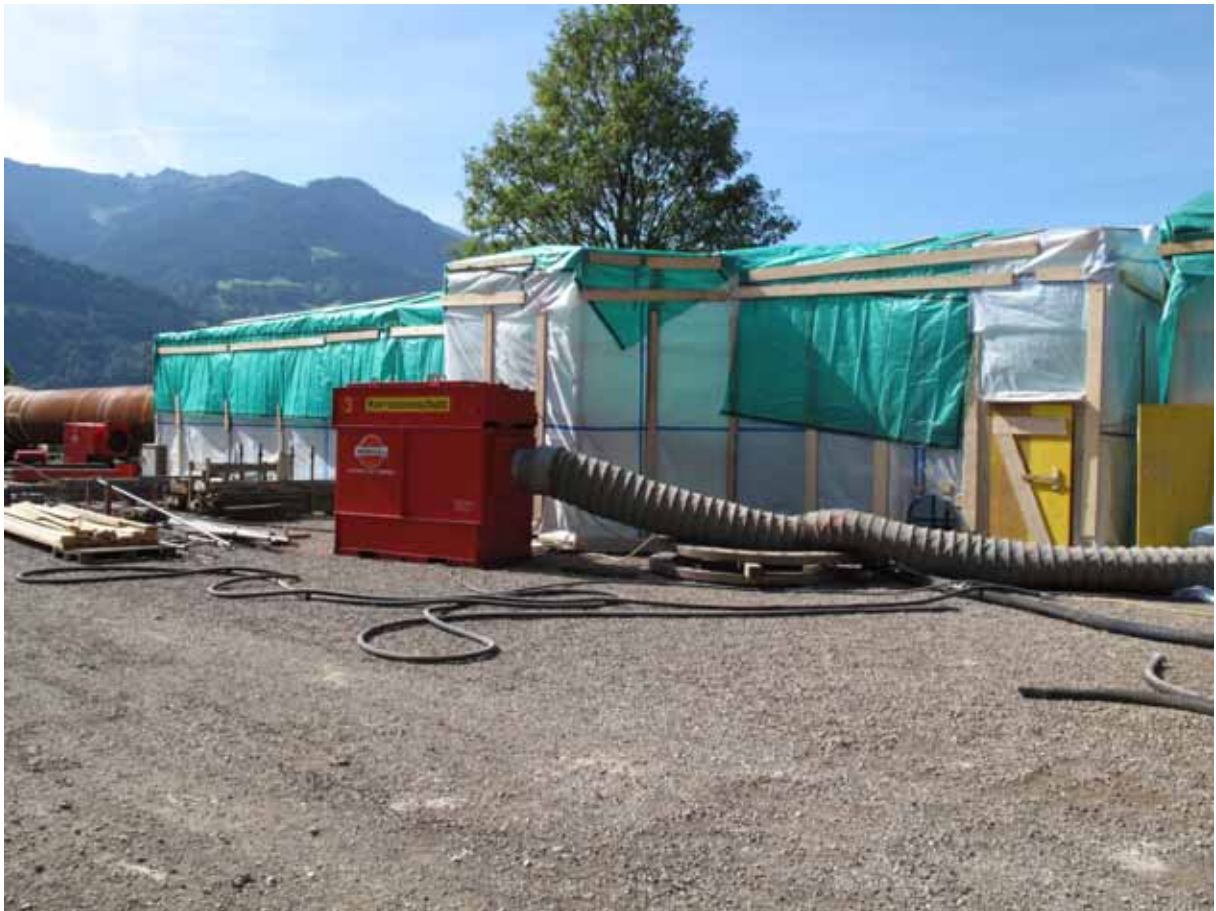
Bild: Einhausung und Klimatisierung der einzelnen Teile der neuen Verteilrohrleitung
