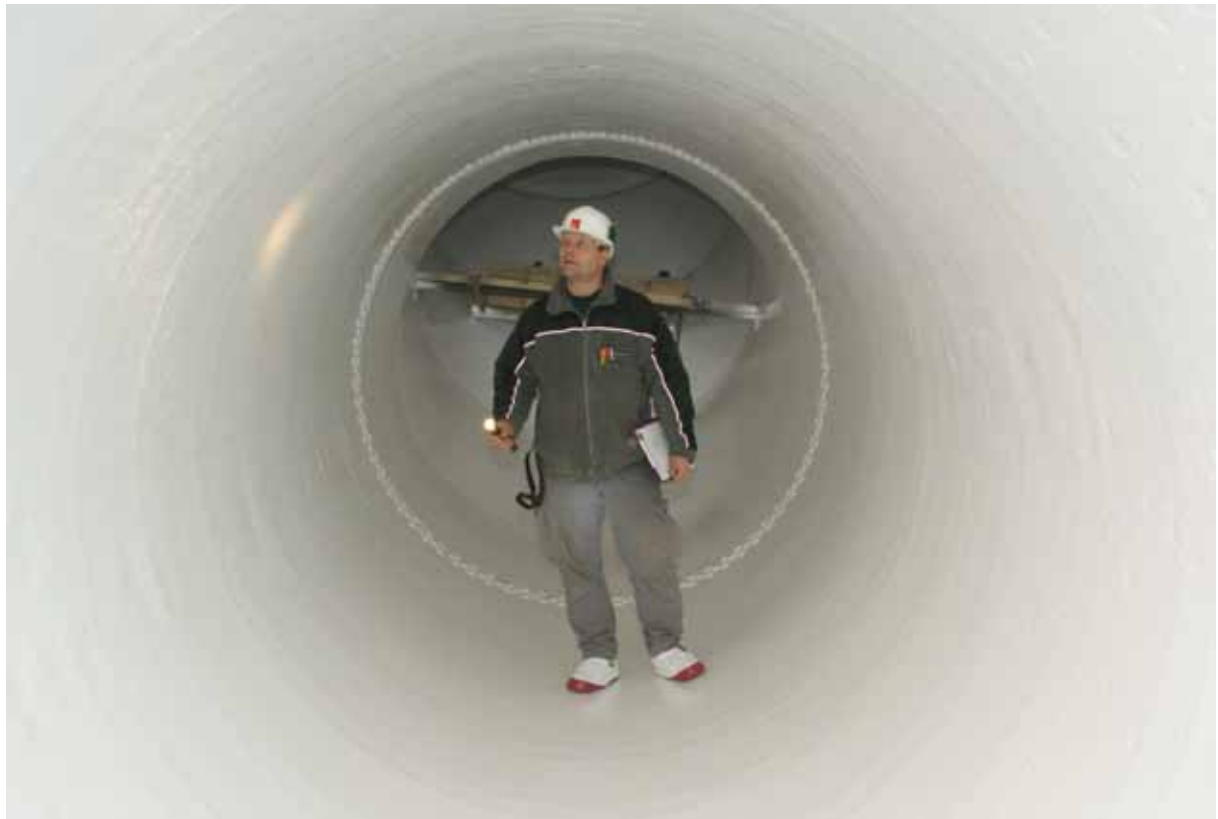
Bild: Fertig beschichtete Innenseite im Bereich des Krümmers des Druckschachtes.
