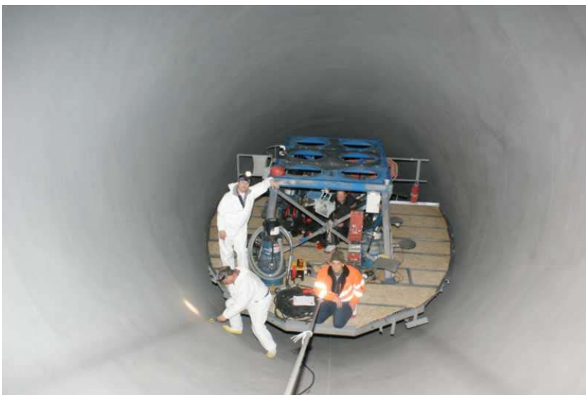
Sandstrahlabnahme im Druckschacht, letzte Kontrolle der Reinigung (Klebebandtest) vor Freigabe zur Beschichtung.
