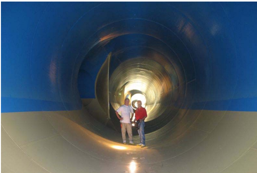
Das Bild zeigt die fertige Beschichtung der Oberwasserverteilerrohrleitung mit Sohl- und Sichelverstärkung.
