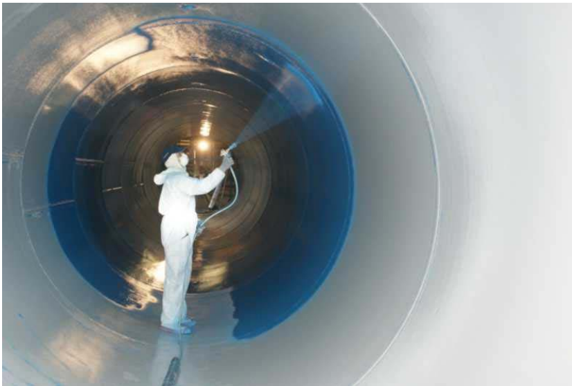
Applikation der zweiten Schicht Humidur in der Lindau-Überleitung.
