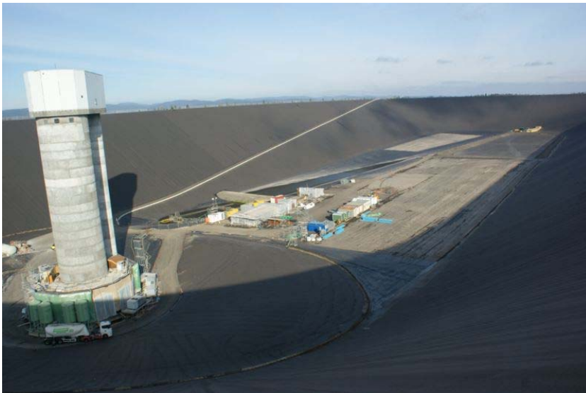
Das nebenstehende Bild zeigt das Speicherbecken mit der Baustelleneinrichtung
